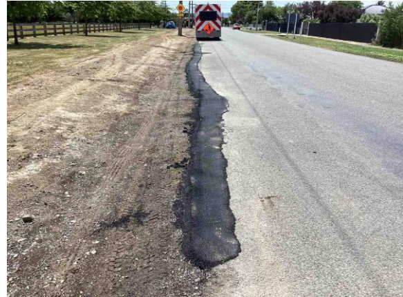
Edge break repairs
