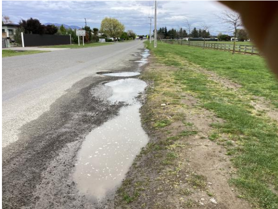
Edge break repairs
