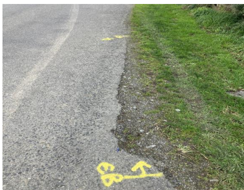
Edge break repairs
