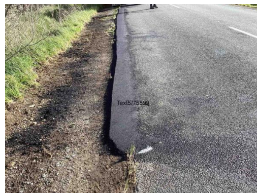
Edge break repairs
