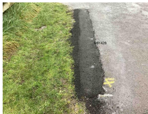
Edge break repairs
