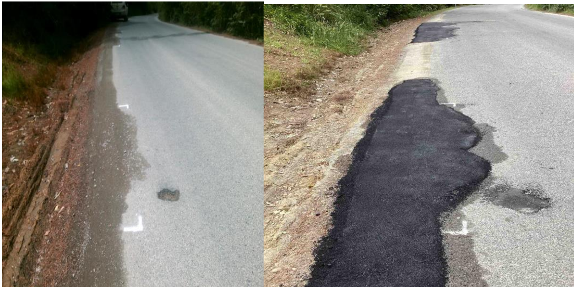
Edge break repairs on Te Wharau Rd
