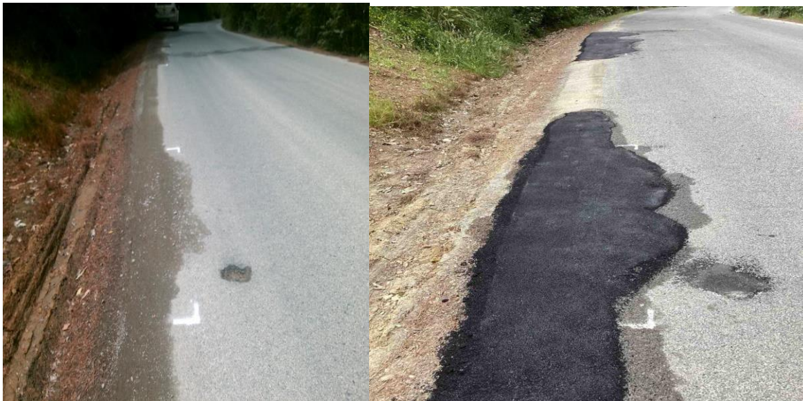
Edge break repairs on Te Wharau Rd
